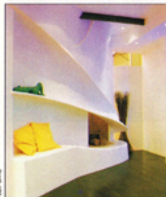
Contemporaine cette cheminée a été réalisée sur place avec des matériaux tel que le plâtre.
